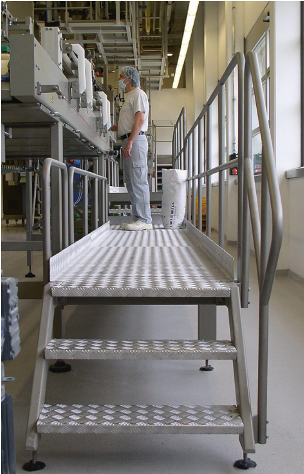
4 Die Kontrollbühne entlang einer automatischen Verarbeitungsanlage ist beidseitig mit einem Geländer gesichert. Geländer sind erforderlich, weil die Absturzhöhe mehr als 500mm beträgt.
