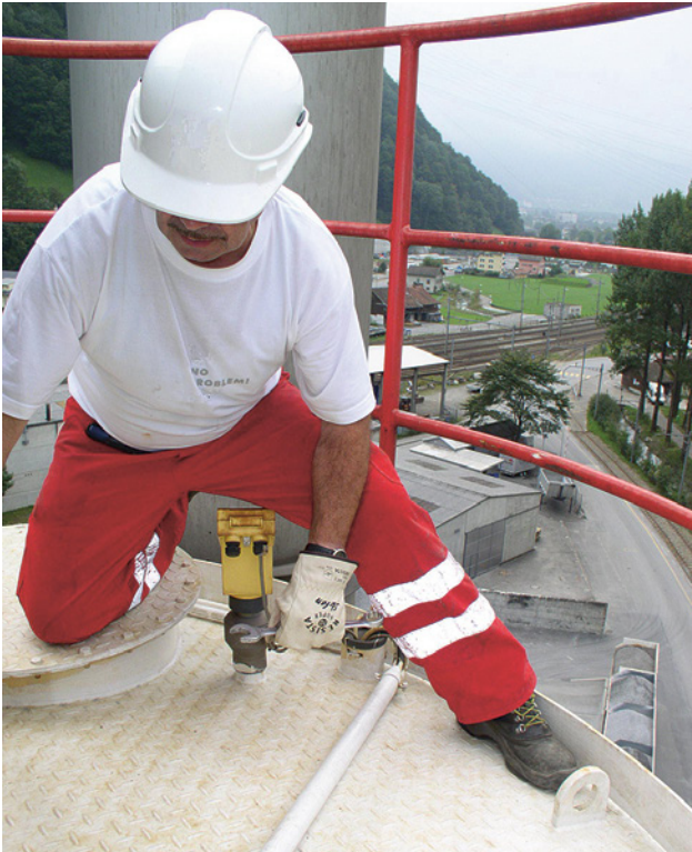
19 Die Fussleiste von mindestens 100mm Höhe verhindert, dass Personen bei Wartungsarbeiten unter dem Geländer wegrutschen oder, dass Gegenstände hinunterfallen und Personen gefährden.
