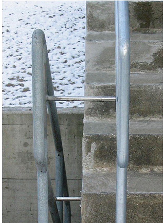
15 Geländer mit genügend Freiraum zwischen Handlauf und Treppe. Das Ende des Handlaufs ist so gestaltet, dass keine Verletzungen durch scharfe Kanten und kein Hängenbleiben mit der Kleidung möglich ist.
