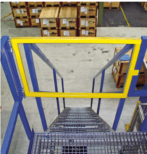
23 Geländer aus einzelnen, abgerundeten Segmenten. Der Freiraum zwischen den Geländersegmenten beträgt mindestens 50mm und höchstens 80mm. So bleibt man mit der Hand nicht in den Freiräumen hängen und kann nicht zwischen den Segmenten herunterfallen.
