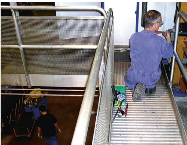
20 Geländer entlang einer Arbeitsbühne mit Fussleisten und einer vollflächigen Füllung auf der Absturzseite. Dadurch wird verhindert, dass kauernde Personen oder Gegenstände auf den darunterliegenden Verkehrsweg abstürzen.
